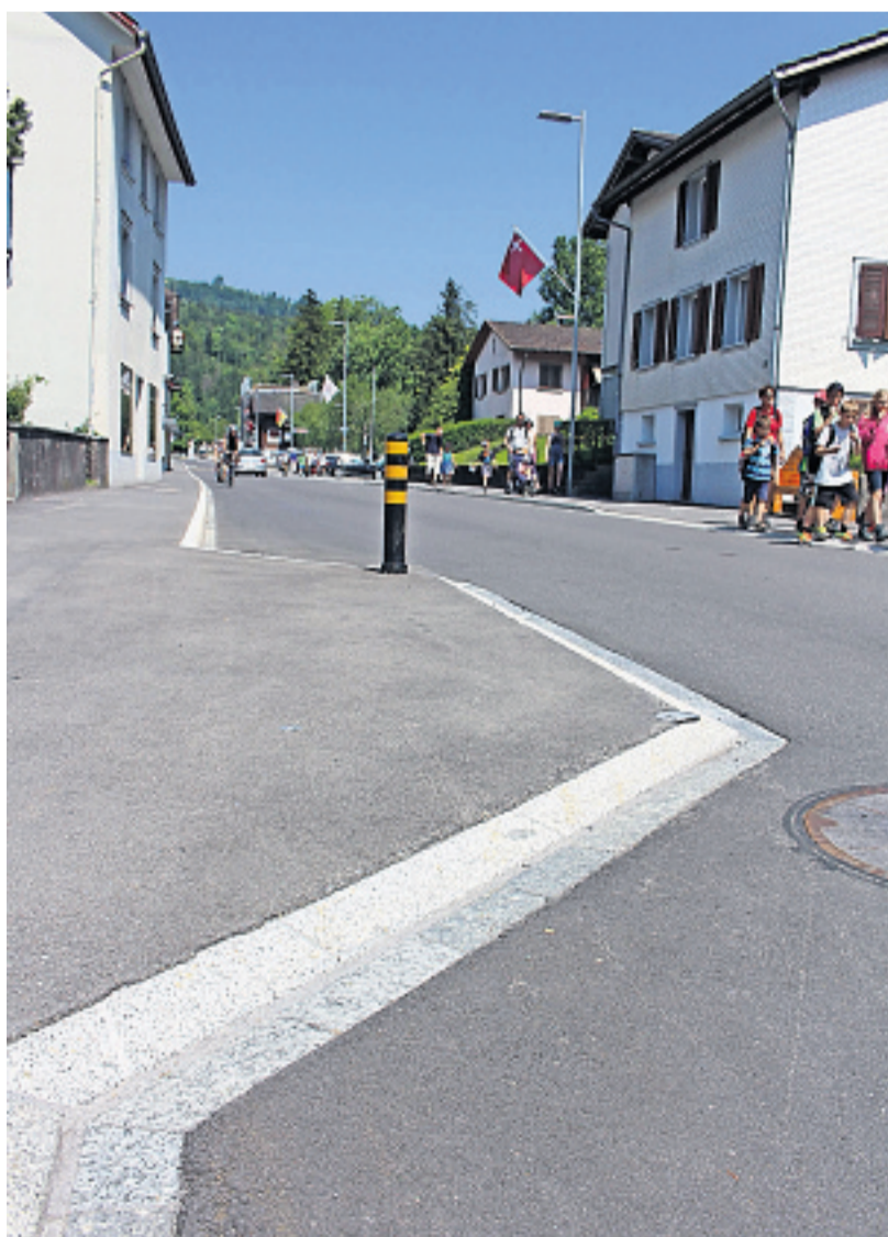
Zwei der vier Fahrbahneinengungen auf der Parkstrasse werden zurückgebaut.
