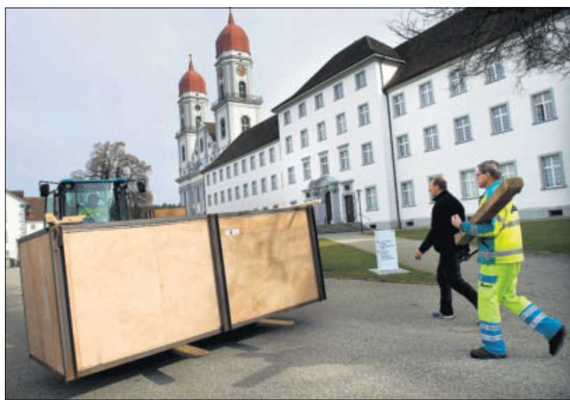
Aufbauarbeiten gestern Vormittag vor der Klosterkirche St. Urban. Bild Eveline Beerkircher
